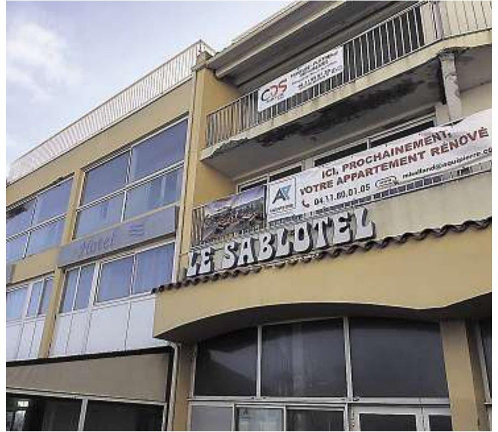
Un programme de 25 appartements est en cours de réalisation sur la place du Môle.
